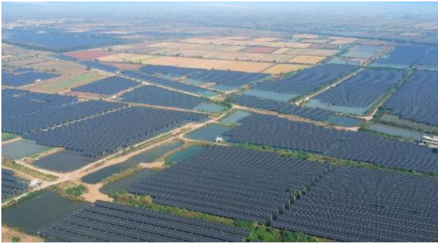
湖北 200MW 渔光互补光伏电站
